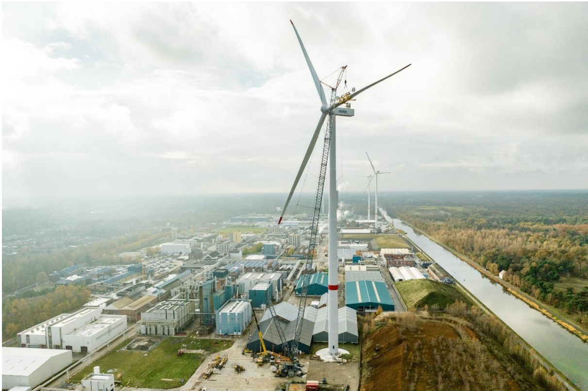
Figuur 1: Opbouw windturbine Umicore Olen in oktober 2023 © Jokko
