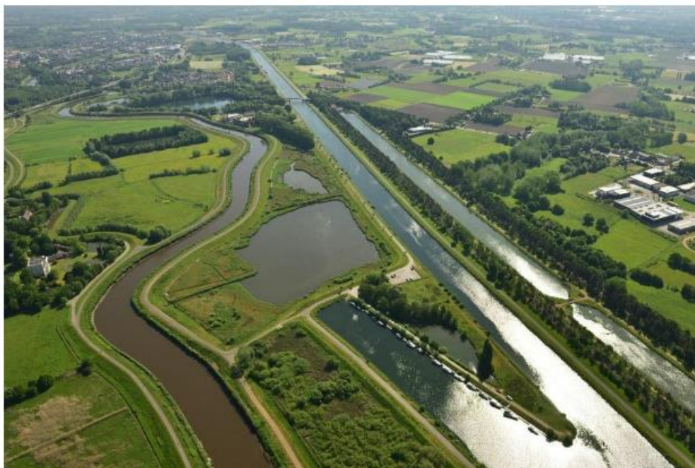
De Beneden-Nete en het Netekanaal in Lier, waar pompinstallaties in gebruik zijn. — © De Vlaamse Waterweg/Yves Adams
